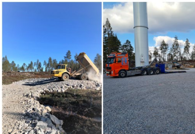
Figur 27 Anläggningsarbete som utförs av lokala underentreprenörer i vindpark Knöstad, Säfte kommun.
