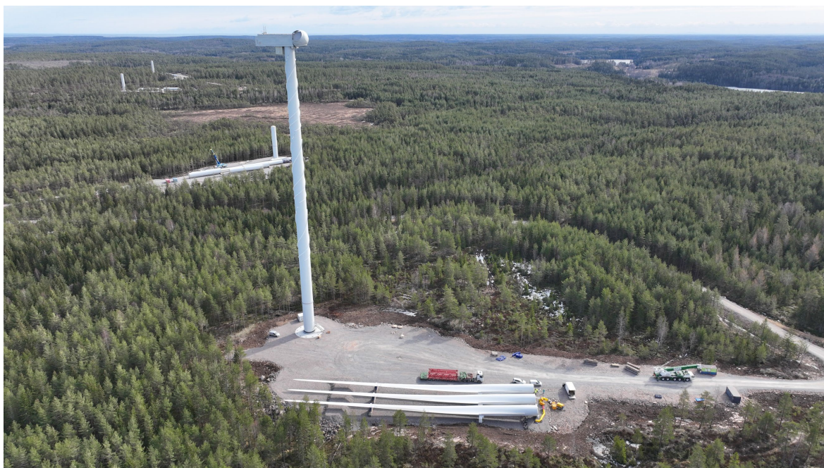
Figur 5 Eurowind Energy monterar vindkraftverk, typ Siemens Gamesa SG-170 med 200 m totalhöjd.
