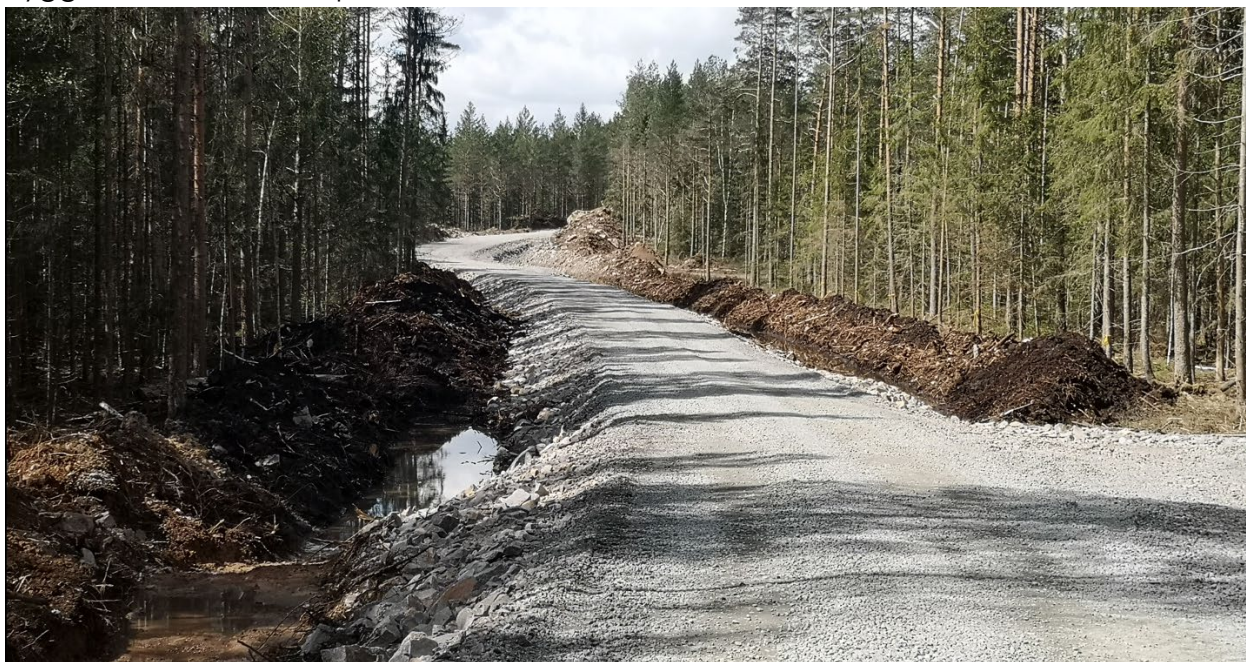
Figur 7 Exempel på breddning av befintlig väg.
