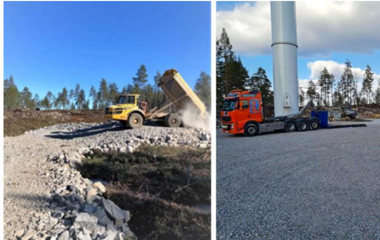
Figur 39 Anläggningsarbete som utförs av lokala underentreprenörer i vindpark Knöstad, Säffle kommun.
