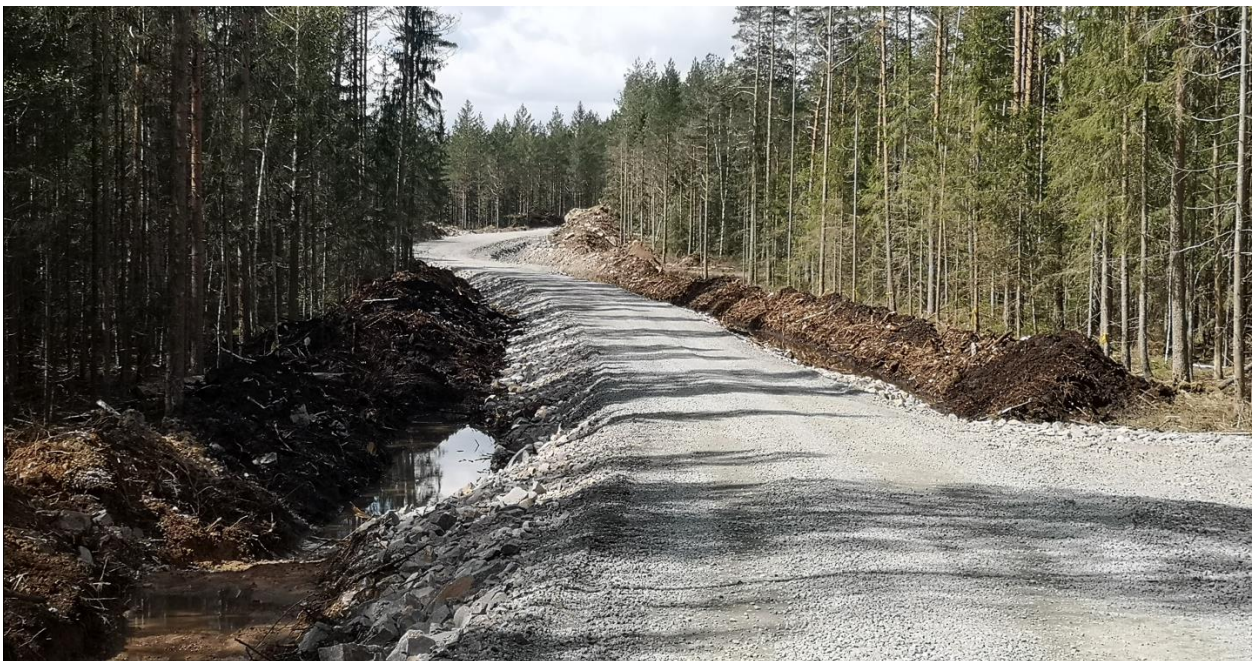
Figur 10 Exempel på breddning av en befintlig väg.
