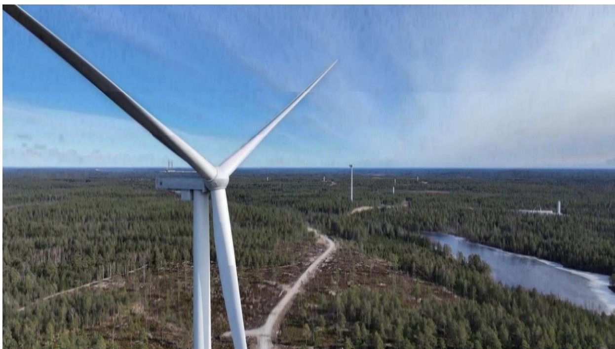
Foto från byggnationen av vindpark Knöstad, Sjöfalle kommun
