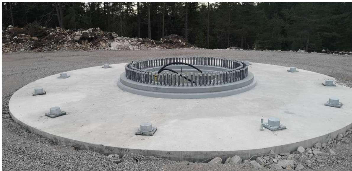
Figur 9 Eurowind bygger bergsförankrad fundament till ett vindkraftverk, typ Siemens Gamesa SG170 med 200 m totalhöjd.
