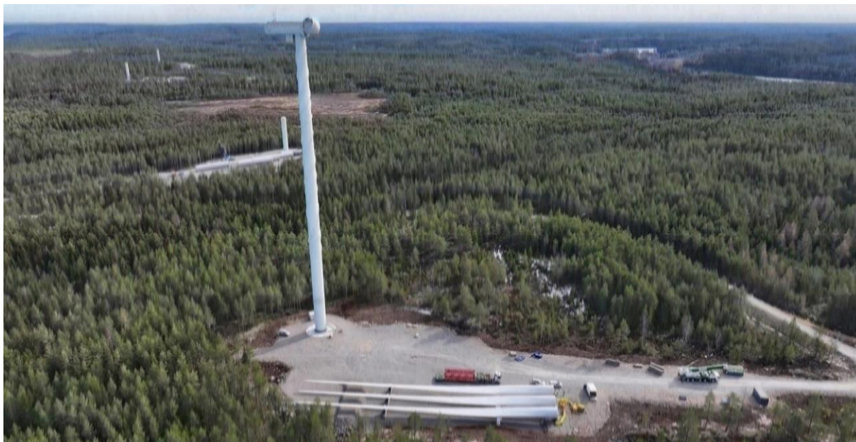
Figur 8 Eurowind monterar vindkraftverk, typ Siemens Gamesa SG-170 med 200 m totalhöjd.
