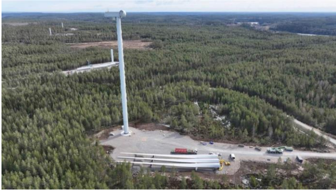
Figur 5. Bild från när Eurowind Energy monterade vindkraftverk, typ Siemens Gamesa SG-170 med en totalhöjd om 200 m.
