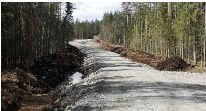
Figur 6. Bild som illustrerar ett exempel på breddning av befintlig väg.
