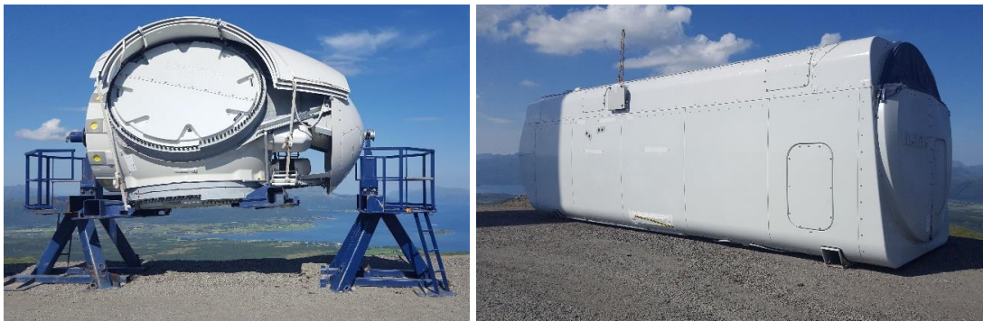
Figur 2. Rotordel i form av navet innan infästning av rotorblad (vänster) och maskinhus (höger) (Foto: Sweco).
