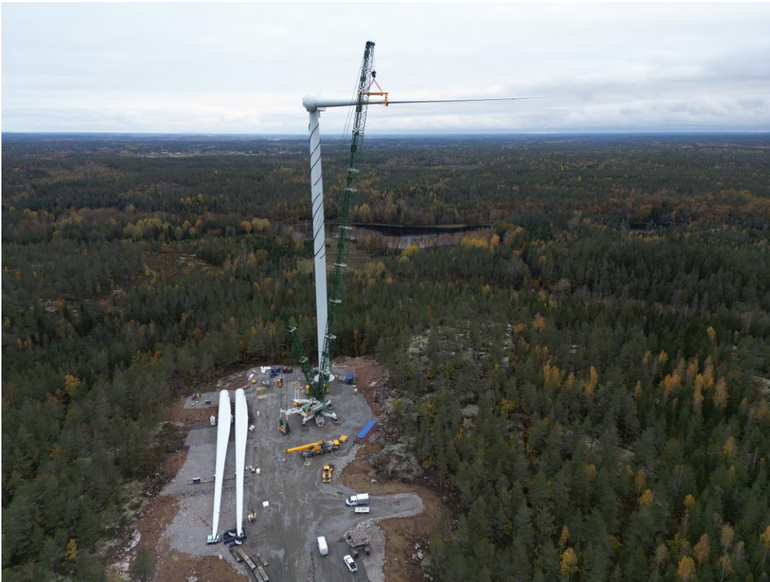
Figur 12. Exempel på installation av rotorblad med huvudkranen (Foto: Eurowind).
