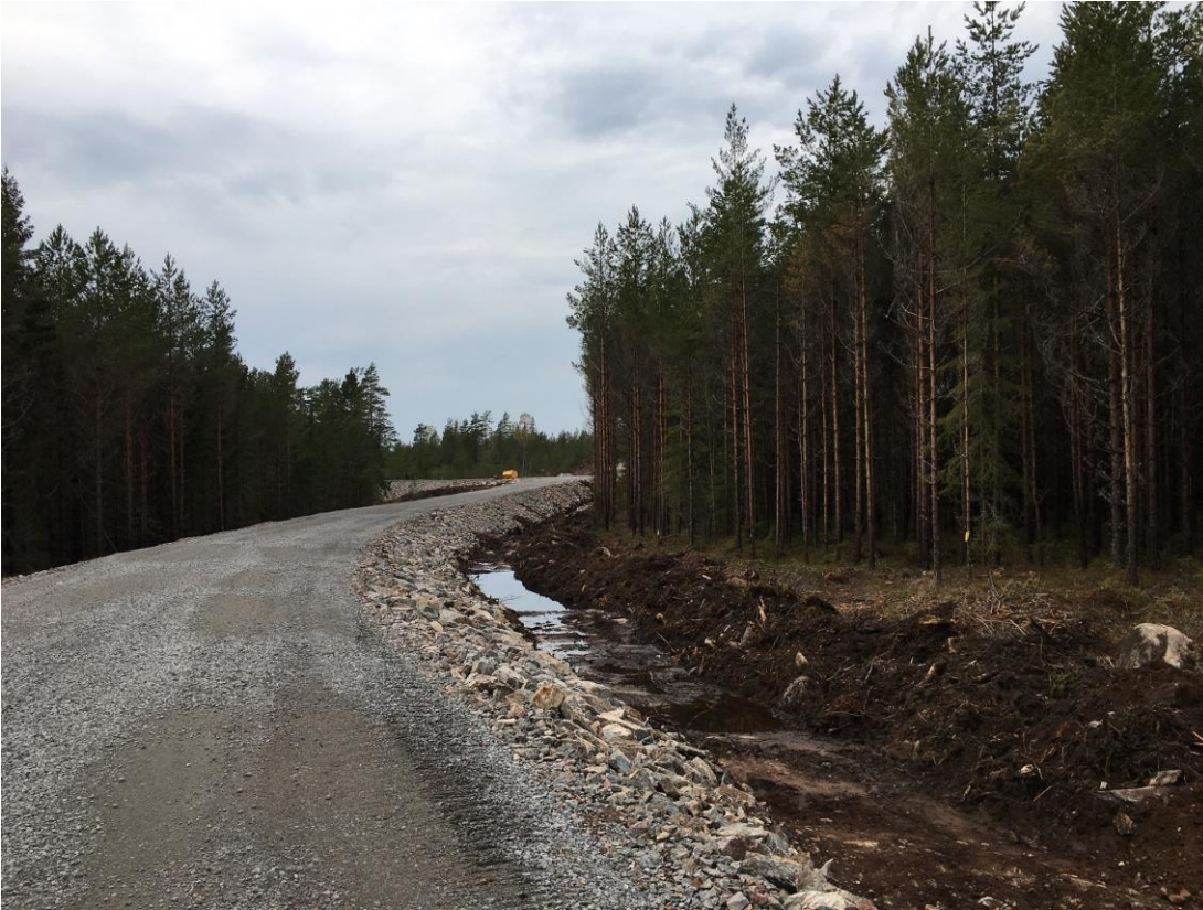
Figur 8. Exempel på breddad väg i befintlig vägsträckning (Foto: Eurowind).
