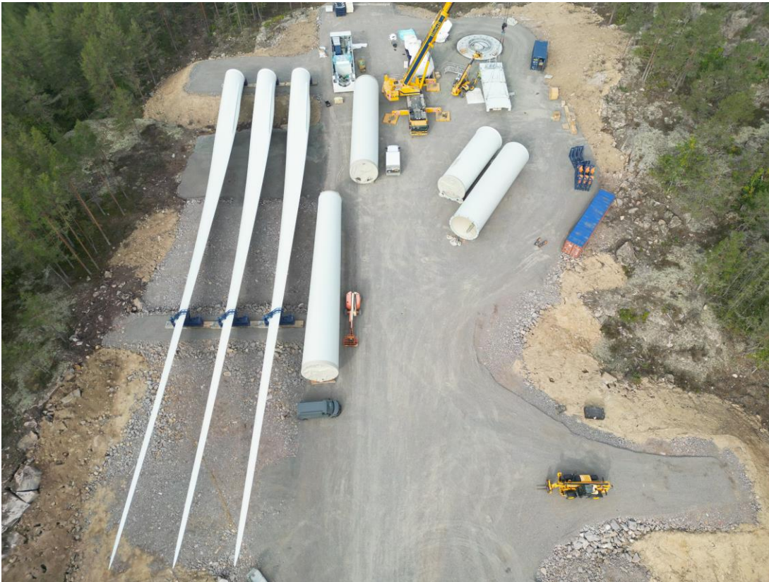
Figur 9. Kran- och montageyta inför resning av vindkraftverk (Foto: Eurowind).
