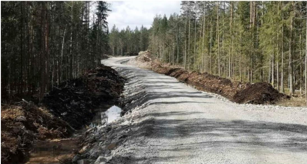
Figur 5. Exempel på breddning av befintlig väg.
