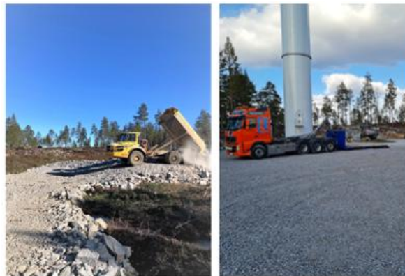
Figur 23. Anläggningsarbete som utförs av lokala underentreprenörer i vindpark Knöstad, Säffle kommun.
