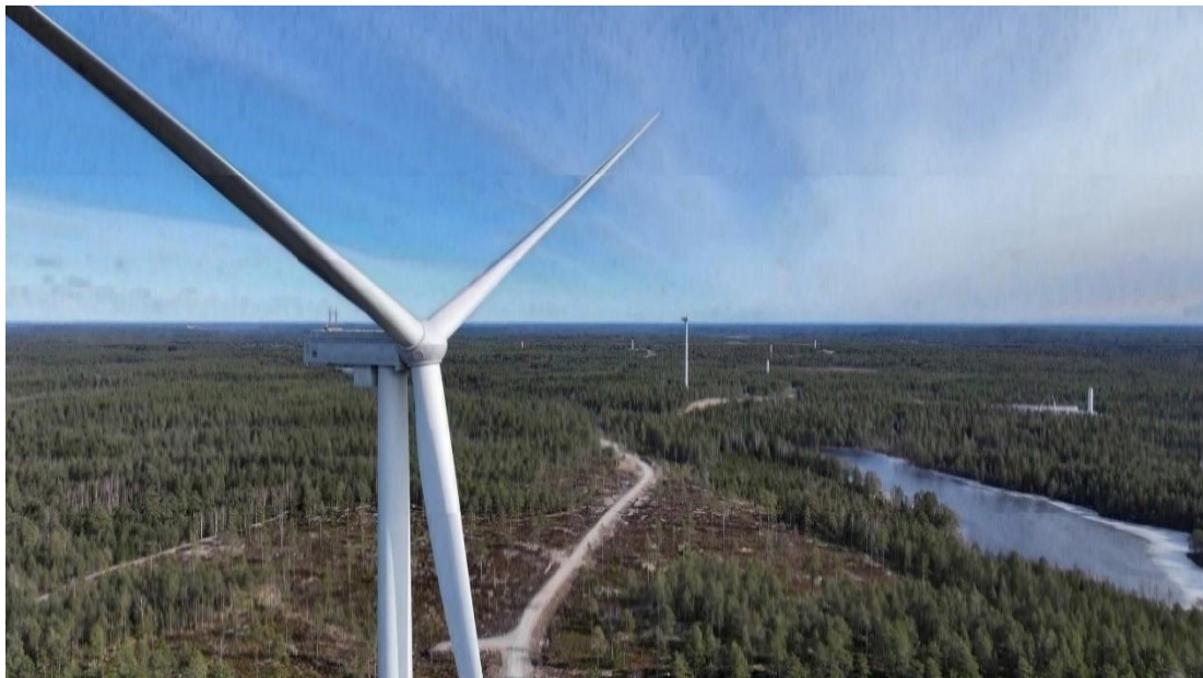
Foto från byggnationen av vindpark Knöstad, Säfle kommun
