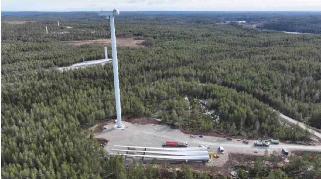
Figur 4. Eurowind monterar vindkraftverk av typen Siemens Gamesa SG170 med 200 m totalhöjd.
